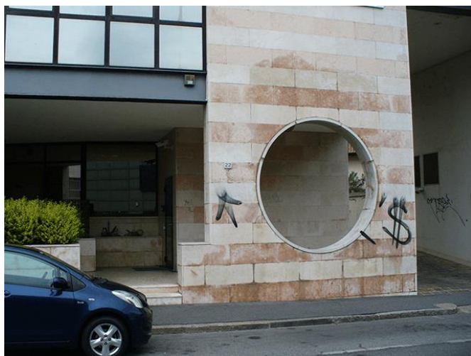
Odstranění graffiti přípravky FREESMOG a SOLVICS a aplikace ochranné antigraffiti úpravy PICASSO.
