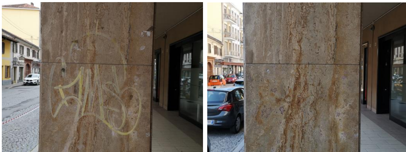
Odstranění graffiti přípravky FREESMOG a SOLVICS a aplikace ochranné antigraffiti úpravy PICASSO.
