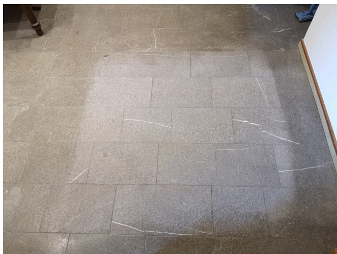
První foto – čištění a odstranění voskové úpravy z kamene Piasentina.
