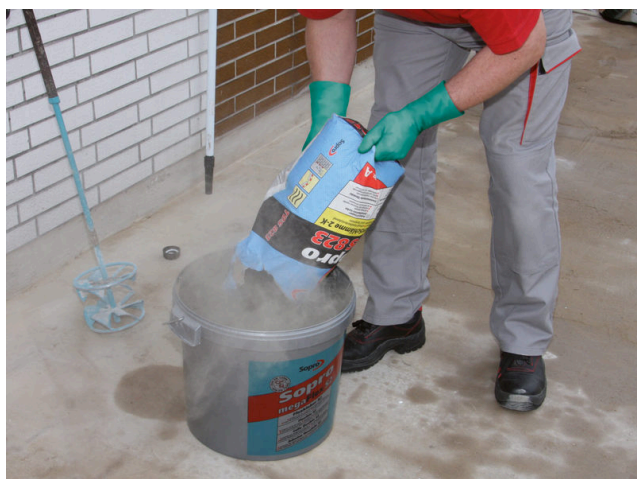
Přidání suché složky Sopro TurboDichtSchlämme 2-K.
