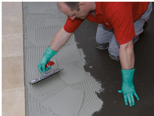
Nanesení dvousložkového flexibilního lepidla Sopro megaFlex S2 nebo Sopro megaFlex S2 turbo na vytvrzenou hydroizolaci.
