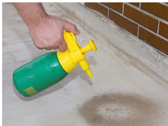
Navlhčení podkladu v exteriéru pro následné nanesení Sopro TurboDichtSchlämme 2-K. Podklady v interiéru je nutné předem ošetřit penetrací Sopro Grundierung.
