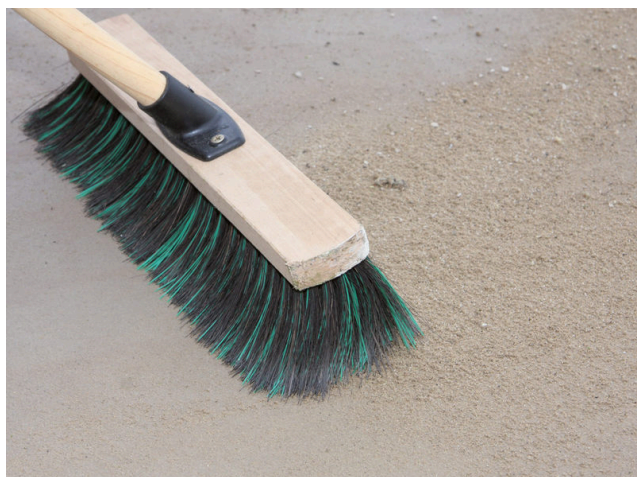
Očištění připraveného, rovného podkladu.
