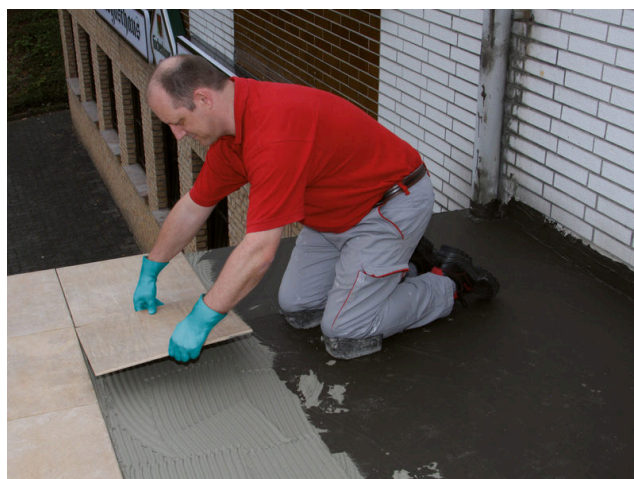
Vkládání a zasouvání desek do čerstvého lepicího lože.
