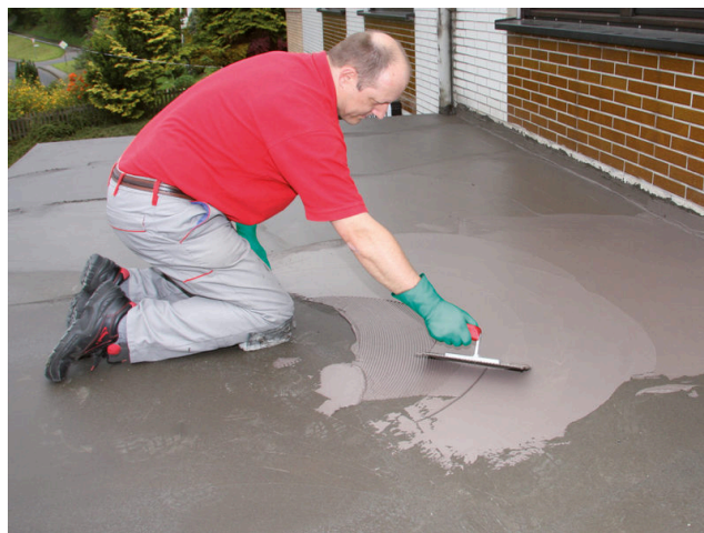
Nanesení 2. vrstvy na 1. hydroizolační vrstvu, proschlou již po 2 hodinách ...
