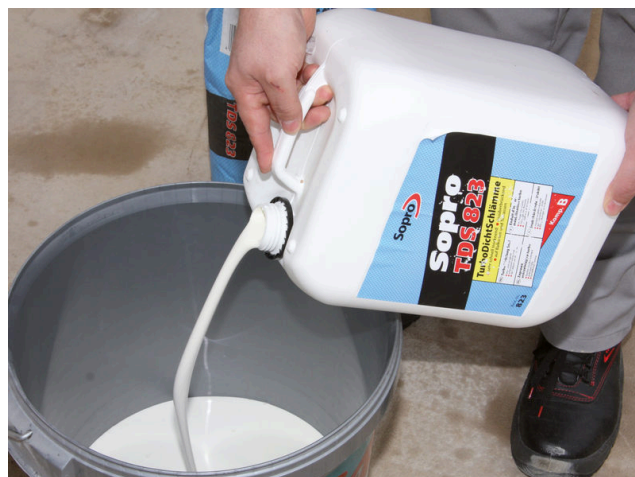
Nalítí tekuté složky Sopro TurboDichtSchlämme 2-K do čistého kbelíku.
