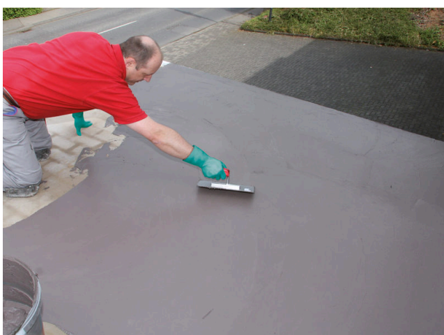
Uhlazení Sopro TurboDichtSchlämme 2-K hladítkem.
