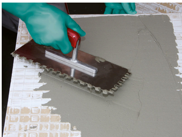
Použití kombinované metody (buttering-floating) závisí na formátu a povaze rubové strany dlažby a slouží k co nejvíce celoplošnému nalepení krytiny.
