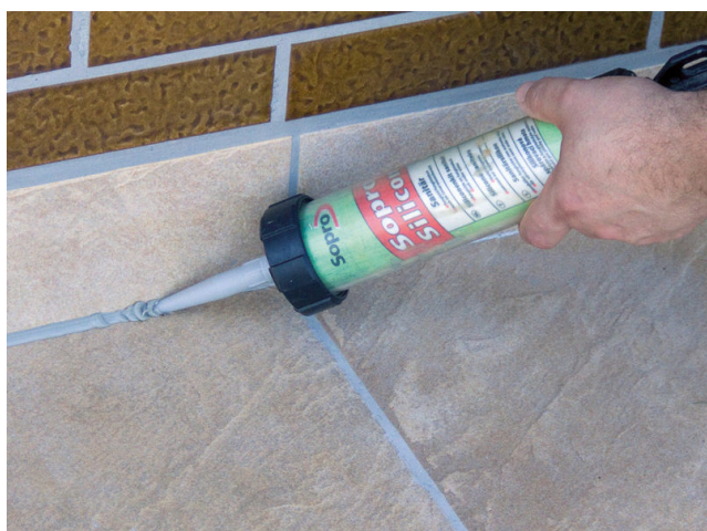
Vyplnění připojovacích a dilatačních spár silikonem Sopro SanitärSilikon.
