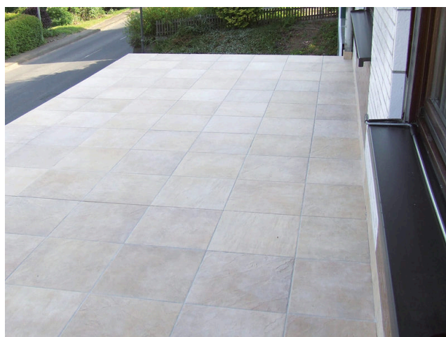
Nově položená krytina na balkoně se systémovými komponentami Sopro.
