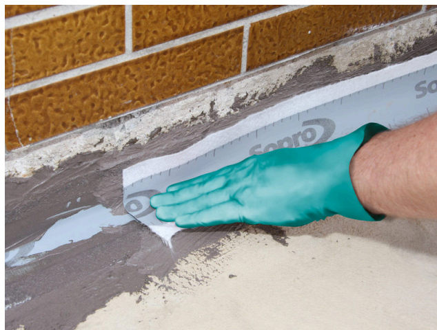
... následně vložené těsnicí pásky Sopro. Tu je nutné navíc vtlačit.
