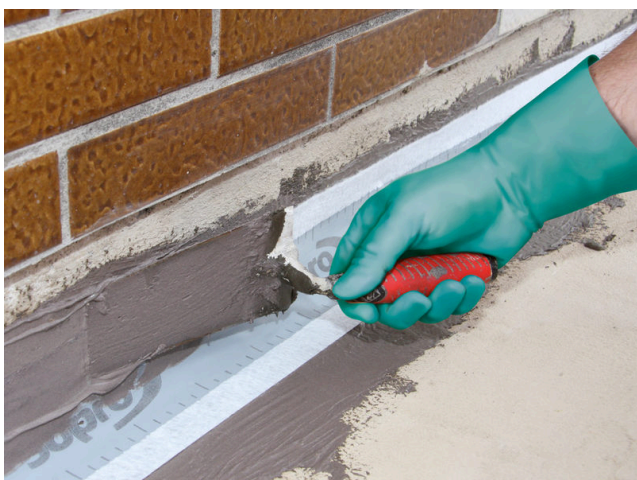
Přestěrkování těsnicí pásky Sopro stěrkou Sopro TurboDichtSchlämme 2-K.
