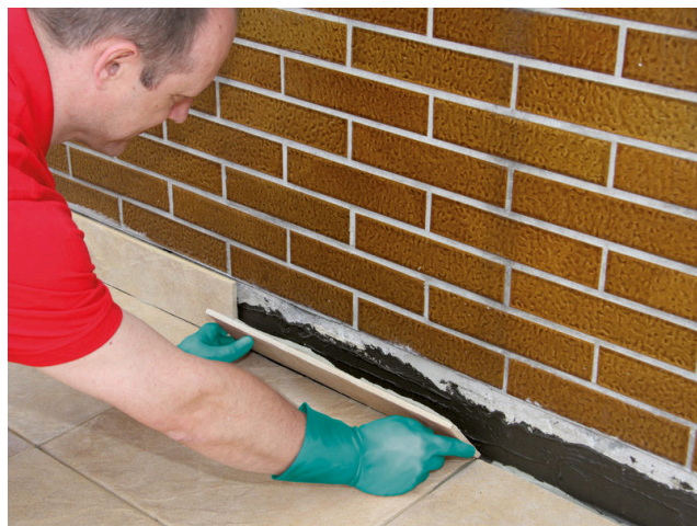
... a osazení soklového obkladu.
