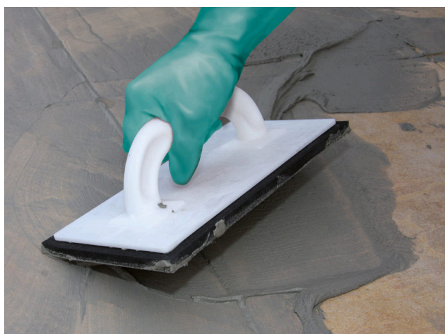
Spárování spárovací maltou Sopro (např. Sopro DF 10® DesignFuge Flex nebo Sopro FlexFuge FL) po zatvrdnutí flexibilního lepidla Sopro
