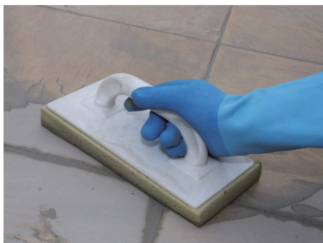
Omytí krytiny po dostatečné době tuhnutí spárovací malty Sopro.
