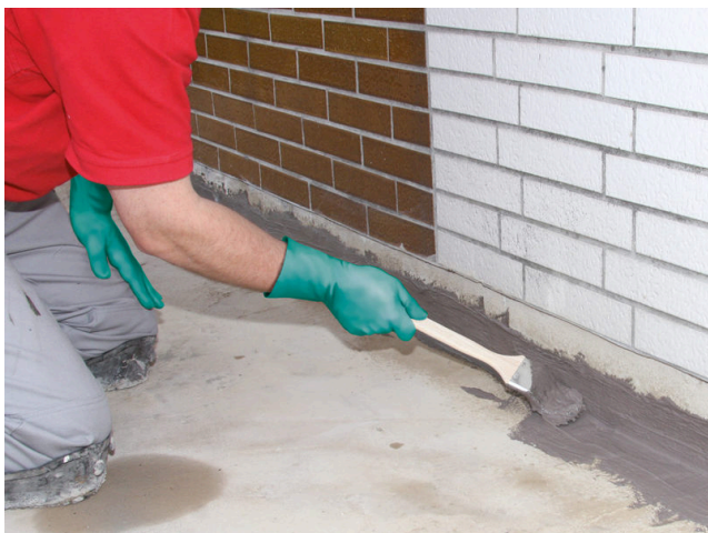
Natření oblasti soklu Sopro TurboDichtSchlämme 2-K k fixaci ...
