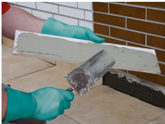
Nanesení flexibilního lepidla Sopro (např. Sopro's No. 1, Sopro FKM® XL) na rub přířeznutého soklového obkladu ...
