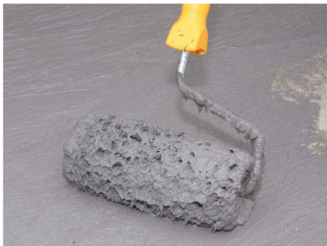
Sopro TurboDichtSchlämme 2-K lze zpracovávat i válečkem z jehněčí kožešiny.
