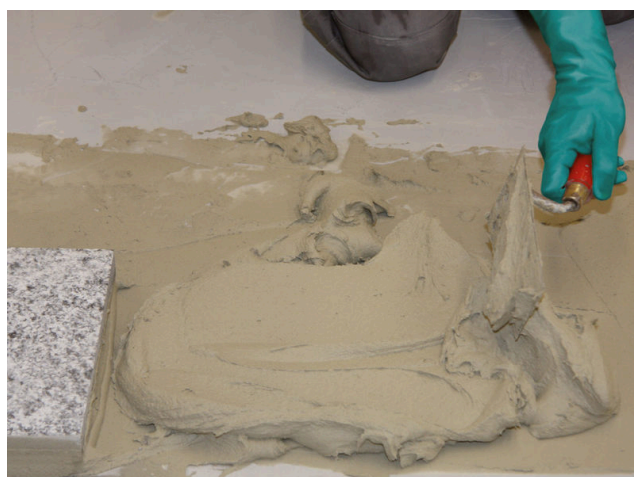
Sopro FKM XL lze pro vyšší tloušťky vrstvy malty do 10 mm zpracovávat i lžící.
