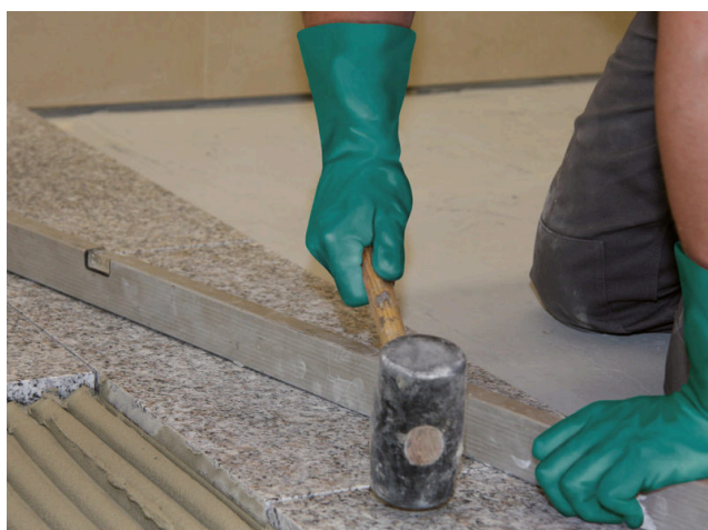
Doklepání desky z přírodního kamene a kontrola rovinnosti.
