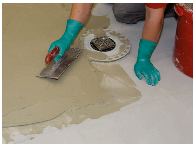
... a vytvořte spád do tloušťky stěrky 10 mm pro následnou hydroizolaci.
