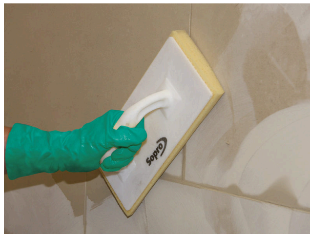
Omytí obkladu po dostatečné době zatvrdnutí naspárované spárovací hmoty Sopro.
