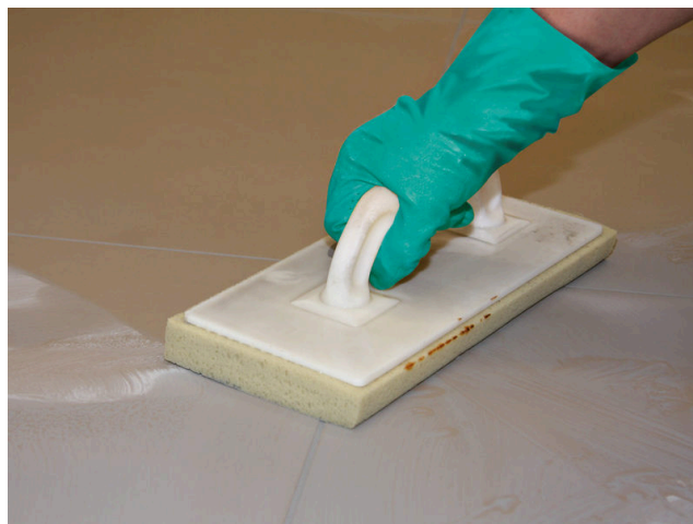
Omytí obkladu po dostatečné době zatvrdnutí naspávané spárovací hmoty Sopro.
