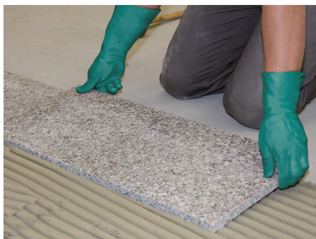
Desku z přírodního kamene uložte a vyrovnejte. Spáry vyškrábněte před vytvrzením.
