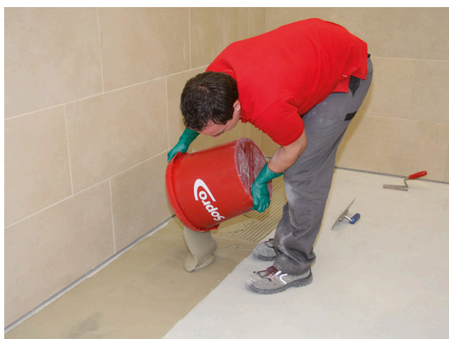
Vylití FKM XL v tekuté konzistenci na připravený podklad.
