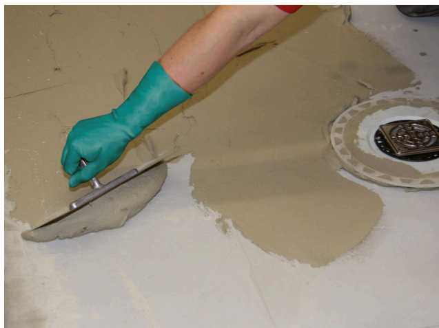
Před nanesením lokální spádové stěrky je nutné nejprve nanést kontaktní vrstvu ze Sopro FKM XL.
