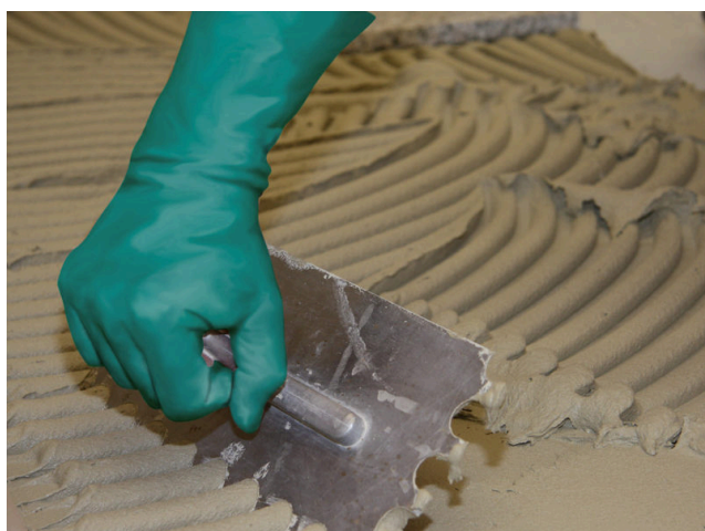
Nanesení Sopro FKM XL hladítkem pro středně silné lože na připravenou kontaktní vrstvu.
