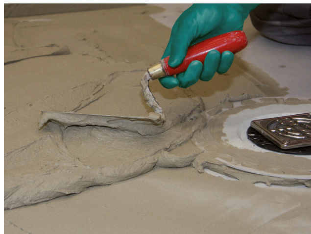
Poté naneste Sopro FKM XL ve stěrkové konzistenci na podklad...
