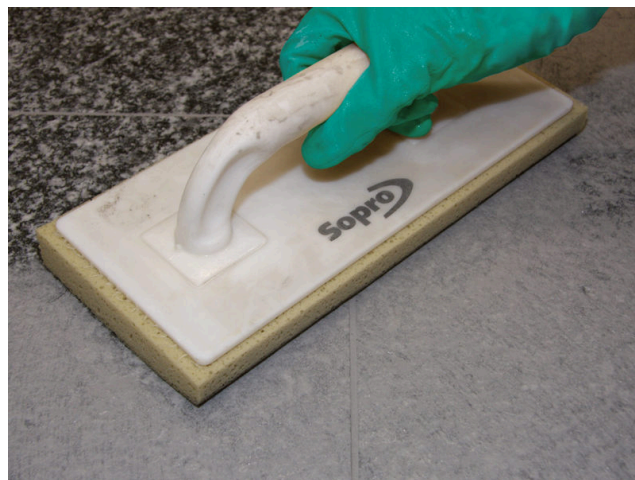
Omytí obkladu z přírodního kamene po dostatečné době zatvrdnutí naspávané spárovací hmoty Sopro.
