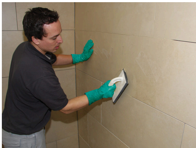
Spárování plochy spárovací hmotou Sopro (např. Sopro DF 10 DesignFuge Flex, Sopro Brillant PerlFuge)
