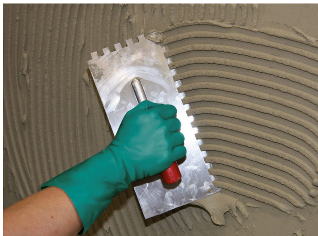
Nanesení žebrovaného lože ve stěnové konzistenci na připravenou kontaktní vrstvu.
