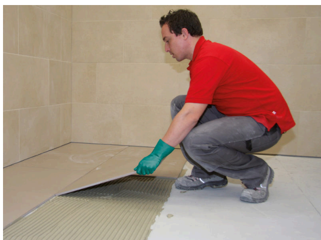
Velkoformátovou jemnou kameninu uložte a vyrovnejte. Spáry vyškrábněte před vytvrzením.
