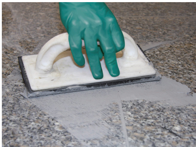
Spárování položeného obkladu z přírodního kamene spárovací hmotou Sopro (např. Sopro DF 10 DesignFuge Flex, Sopro Brilliant PerlFuge).
