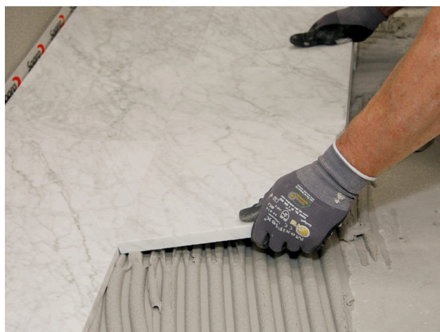
Vkládání desky z přírodního kamene. Díky světlé barvě je Sopro FKM® Silver vhodný i pro pokládku průsvitných materiálů.
