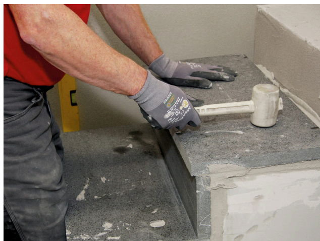
Pokládka schodišťového stupně. Díky rychlému tvrdnutí je možné brzké zatížení.
