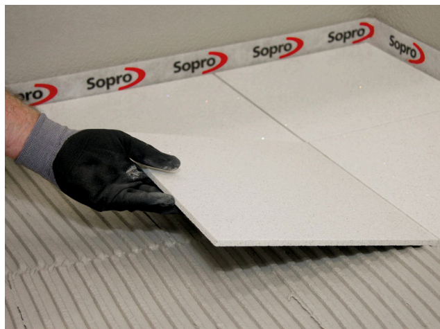
Vkládání aglomerátové desky. Díky rychlému tvrdnutí je Sopro FKM® Silver vhodný i pro pokládku krytin citlivých na deformaci.
