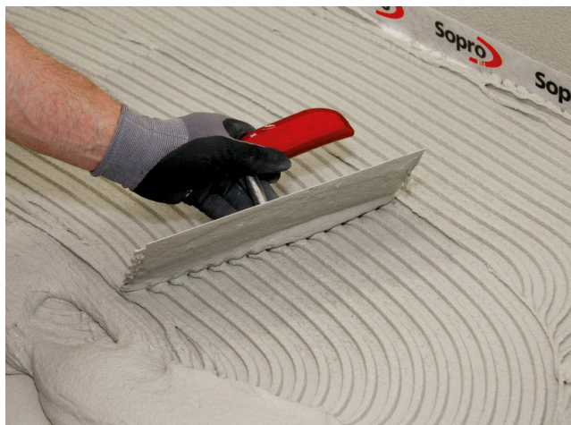
Nanesení kontaktní vrstvy a žebrovaného lože v konzistenci pro tekuté lože.
