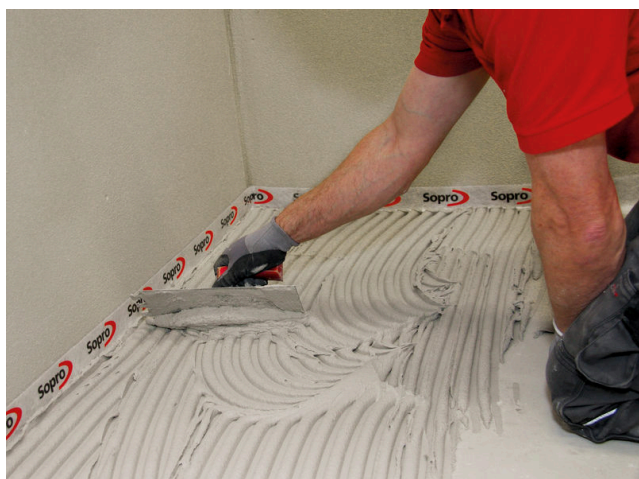
Pro pokládku do středně silného lože naneste Sopro FKM® Silver v konzistenci pro středně silné lože.
