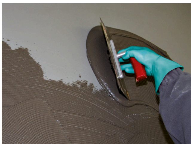
Rozprostření Sopro megaFlex S2 turbo odpovídajícím zubovým hladítkem. (Alternativně lze k lepení pásů nanést válečkem i FDK 415 nebo DSF RS)
