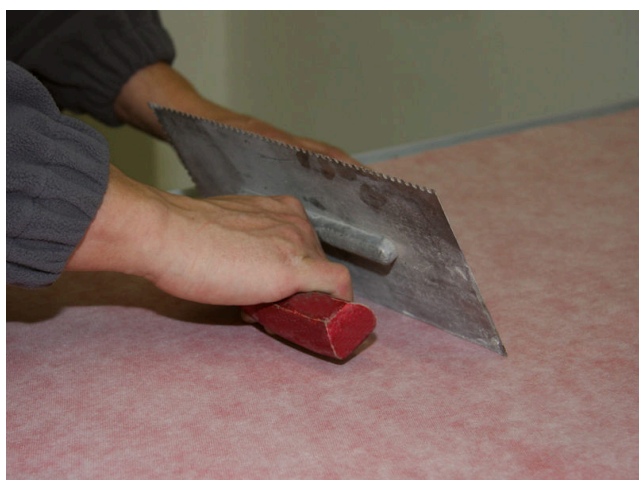
Sopro AEB® plus přitlačte hladítkem nebo třmenem malířského válečku a stáhněte tak, aby pod pásem nezůstaly vzduchové bubliny.
