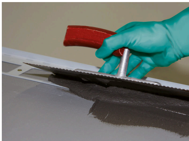
Otevřené stojiny žlabových profilů se vyplní Sopro megaFlex S2 turbo.
