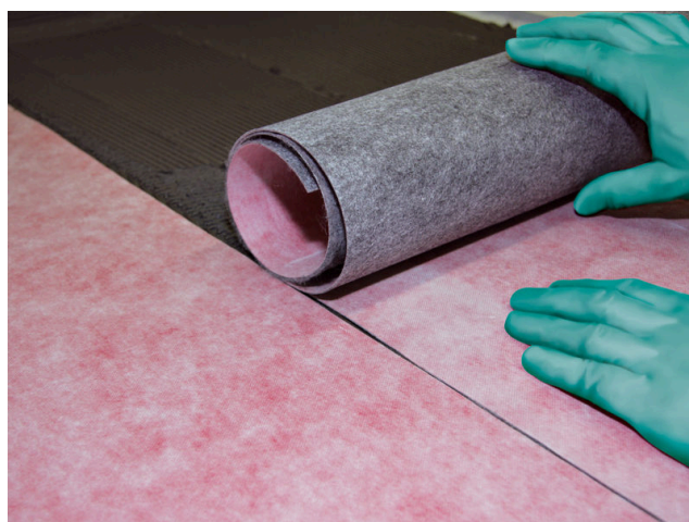
Navazující druhý pás se přilepí na tupo k prvnímu pásu.
