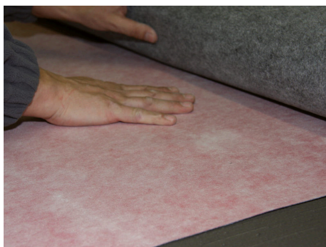
Přesně přiříznuté jednotlivé pásy Sopro AEB® plus se šedou stranou dolů celoplošně vloží do čerstvého lepicího lože.
