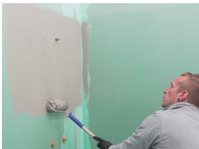
Sopro Fixier- & DichtKleber nebo Sopro DichtSchlämme Flex RS naneste celoplošně válečkem.
