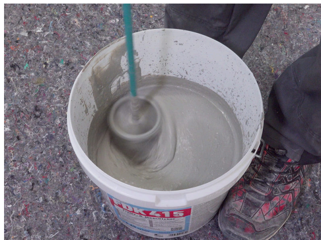
FDK 415: Do nádoby nalijte tekutou složku a strojně ji rozmíchejte s práškovou složkou. Alternativně: DSF RS rozmíchejte s vodou v předepsaném poměru.
