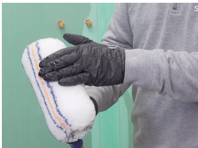
Pro rychlý postup prací použijte k nanášení váleček z jehněčí kožešiny.
