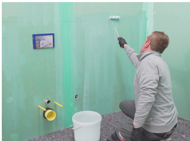
Savé podklady ošetřete penetrací Sopro Grundierung.
