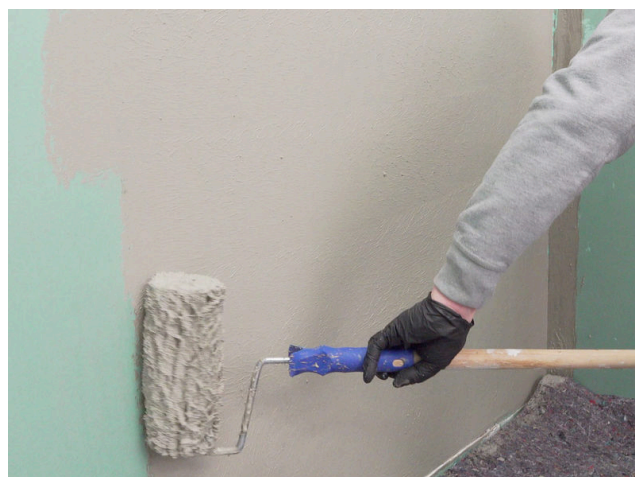
Pro rovnoměrně krycí výsledek naneste Sopro Fixier- & DichtKleber nebo Sopro DichtSchlämme Flex RS křížem.
